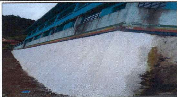
Foto1: Muro de contención de la EORM Aldea El Colmito
